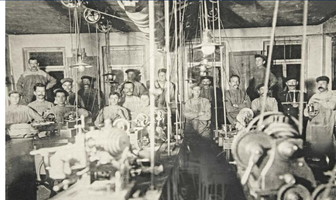
um 1900, ein Gasmotor treibt über eine Transmission an der Decke mittels Lederriemen die einzelnen Maschinen im Produktionssaal an
